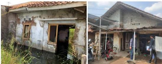
**Gambar 6** Ketinggian Bangunan Rumah Tinggal yang Mengalami Penurunan Akibat Peninggian Level Lantai
