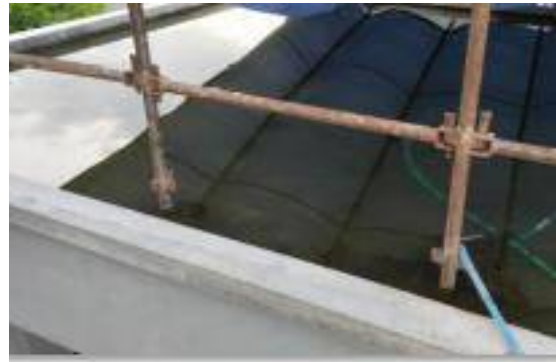
Gambar 9 Pembuatan Tempat Penampungan Air Hujan untuk Digunakan Kembali Dalam Berbagai Kegiatan yang Tidak Diisyaratkan Air Layak Minum
