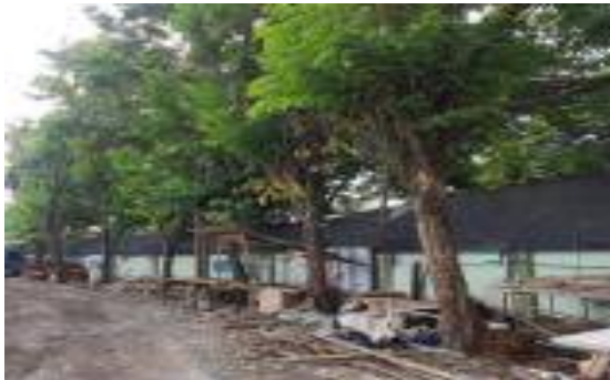
Gambar 7 Mempertahankan Vegetasi Eksisting yang Memungkinkan Selama Proses Konstruksi
