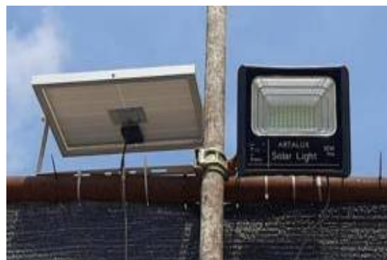
Gambar 10 Memaksimalkan Pemanfaatan Sinar Matahari untuk Penerangan di Kontraktor Keet Paling Tidak 50% dari Jumlah Ruang.
