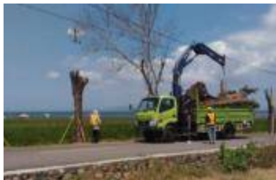
Gambar 8 Pindahan atau Mengganti Vegetasi/ Pohon yang Terkena Dampak Proyek Konstruksi
