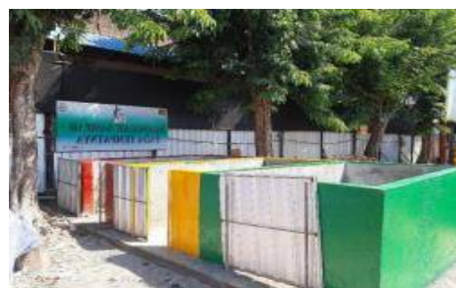
Gambar 5 Tersedianya Tempat Sampah Organik, Anorganik, B3 di Sekitar Lokasi Kerja untuk dilakukan Pemilahan termasuk Sampah Konstruksi
