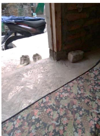
Gambar 4. Bentuk Perbaikan pada Dinding, Atap, Lantai, Dan Pintu
