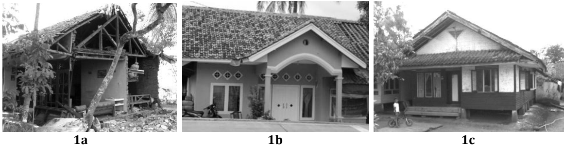
Gambar 1 Bangunan Rumah Tinggal a) Rumah Tinggal dari Dinding Pasangan Tanpa Pengekang, b) Rumah Tinggal dari Dinding Pasangan dengan Pengekang, c) Rumah Tinggal Tradisional Berbasis Kayu
