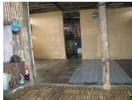
Gambar 10 Struktur Lantai Papan dan Bambu pada Rumah Mengapung
