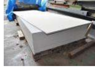
Gambar 2 Papan Semen FCB Digunakan untuk Panel Penutup Rangka Dinding Geser
