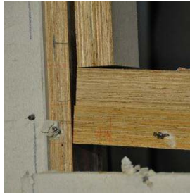
Gambar 22 Panel-B Terlepas Dari Rangka Kayu LVL Dinding Geser Dengan Bukaannya Jendela (SWWOS)
