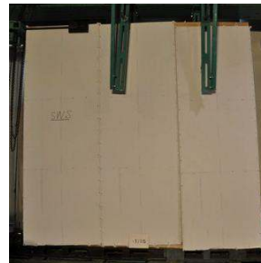
Gambar 18 Kondisi Spesimen Dinding Geser Pada Akhir Pengujian
