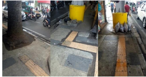
Gambar 13 Jalur Pemandu yang Terhalang Objek/Struktur Permanen
