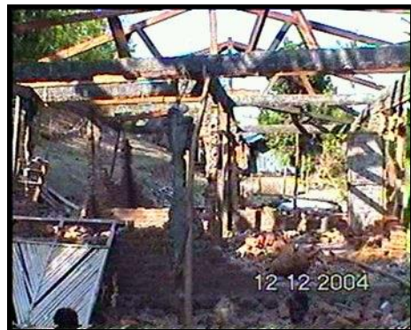
Gambar 2. Rumah Beton dengan Sambungan Kolom dan Balok Tidak Sempurna
