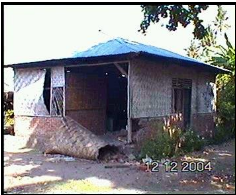
Gambar 1. Rumah Kayu dengan Konstruksi 1/2 Tembok.
