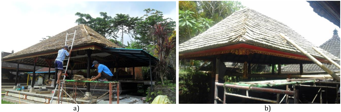
Gambar 8 Pemasangan Sirap Pada Konstruksi Atap: a) Pemasangan Sirap Pada Bale Paruman Agung; b) Pemasangan Sirap Pada Bale Paselang
